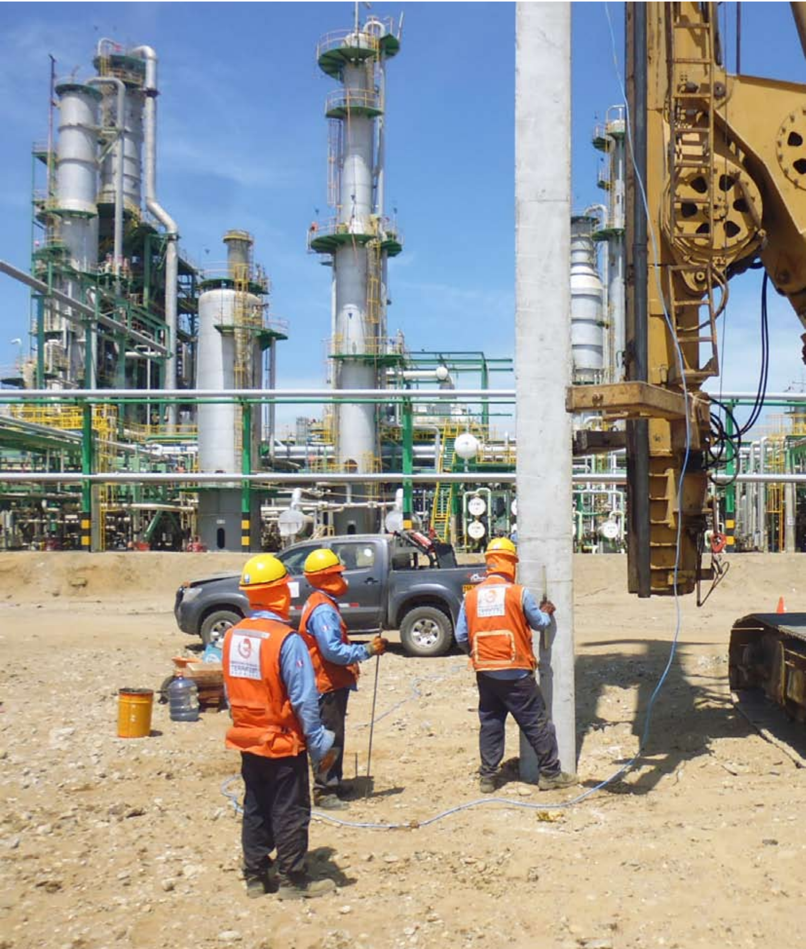
Talara raffinerie Projet de modernisation. Peru Pieux battu en béton
