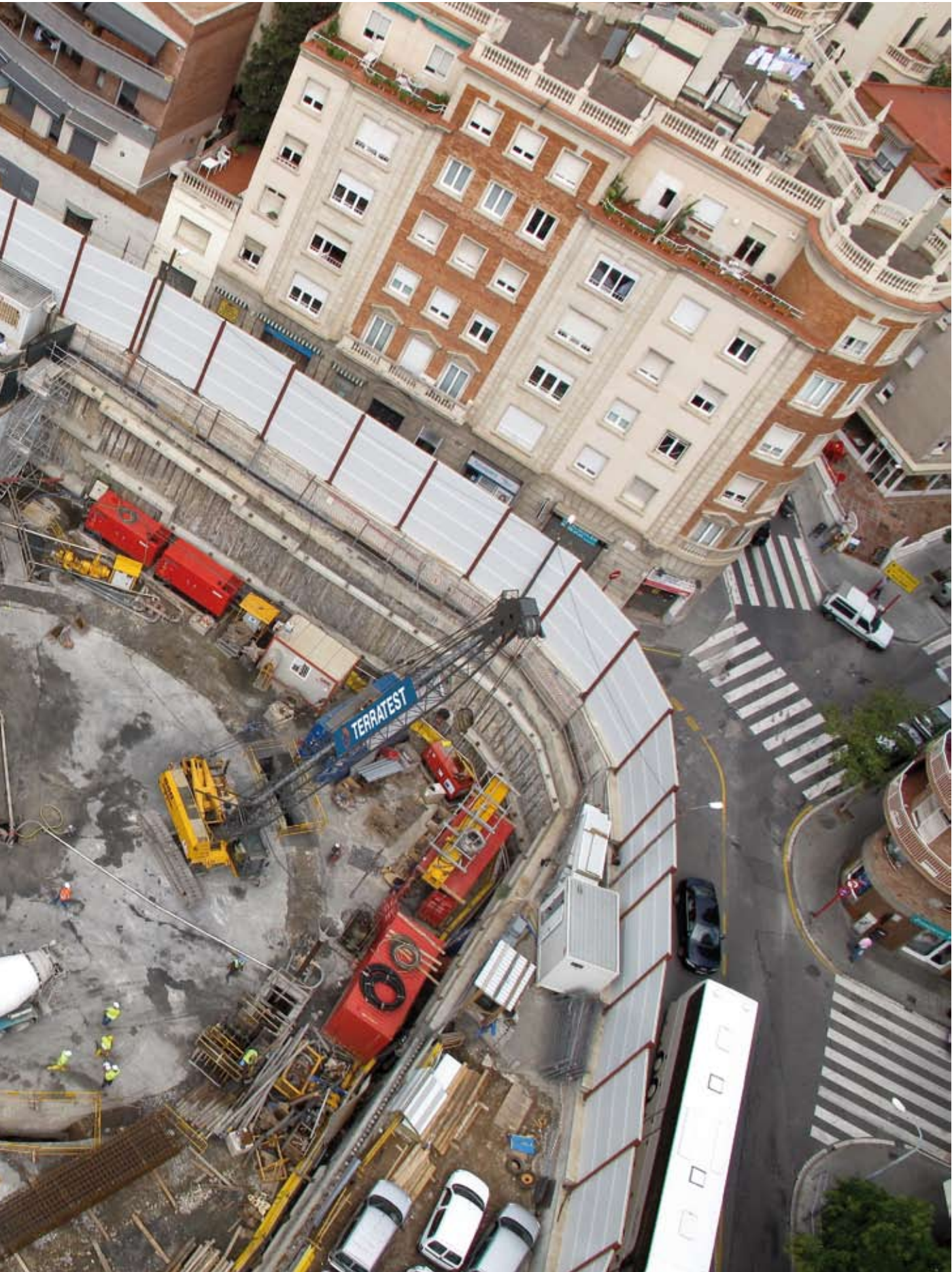
Barcelone métro ligne 9. Plaza Sanllehy, Barcelone, Espagne Ateliers de forage avec Hydrofraise
