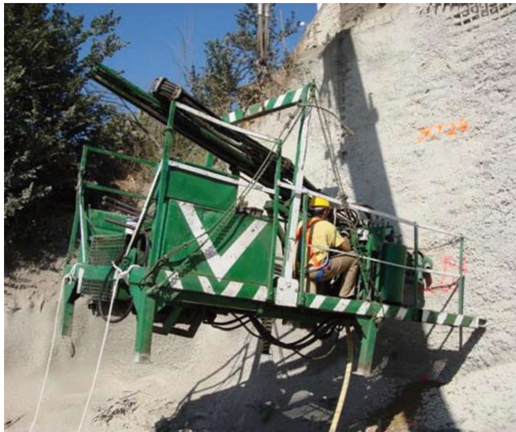
Glissement de terrain à Bonares. Huelva, Espagne Cloutage
