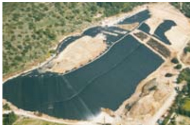
Hydrogéologie environnementale et géotechnique
