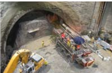
Forage directionnel horizontal
