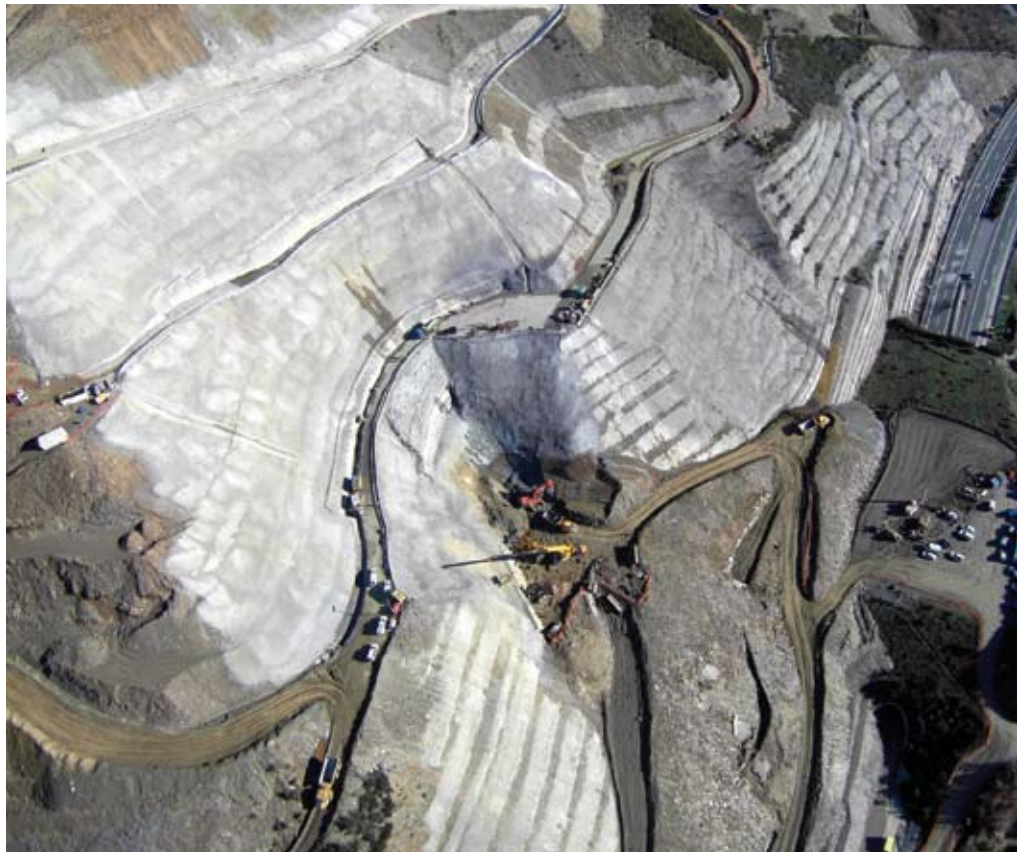
Travaux de contention pour glissement de terrain sur l'autoroute A-6. León, Espagne Ancrages
