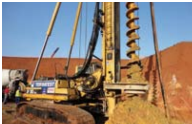
Pieux battu en béton
