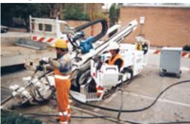
Forage directionnel horizontal
