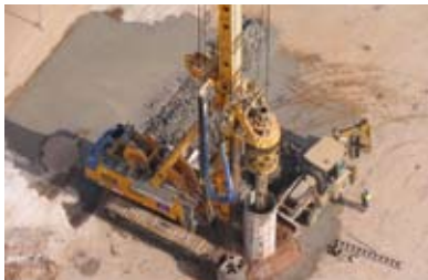
CFA et Inclusion Rigide
