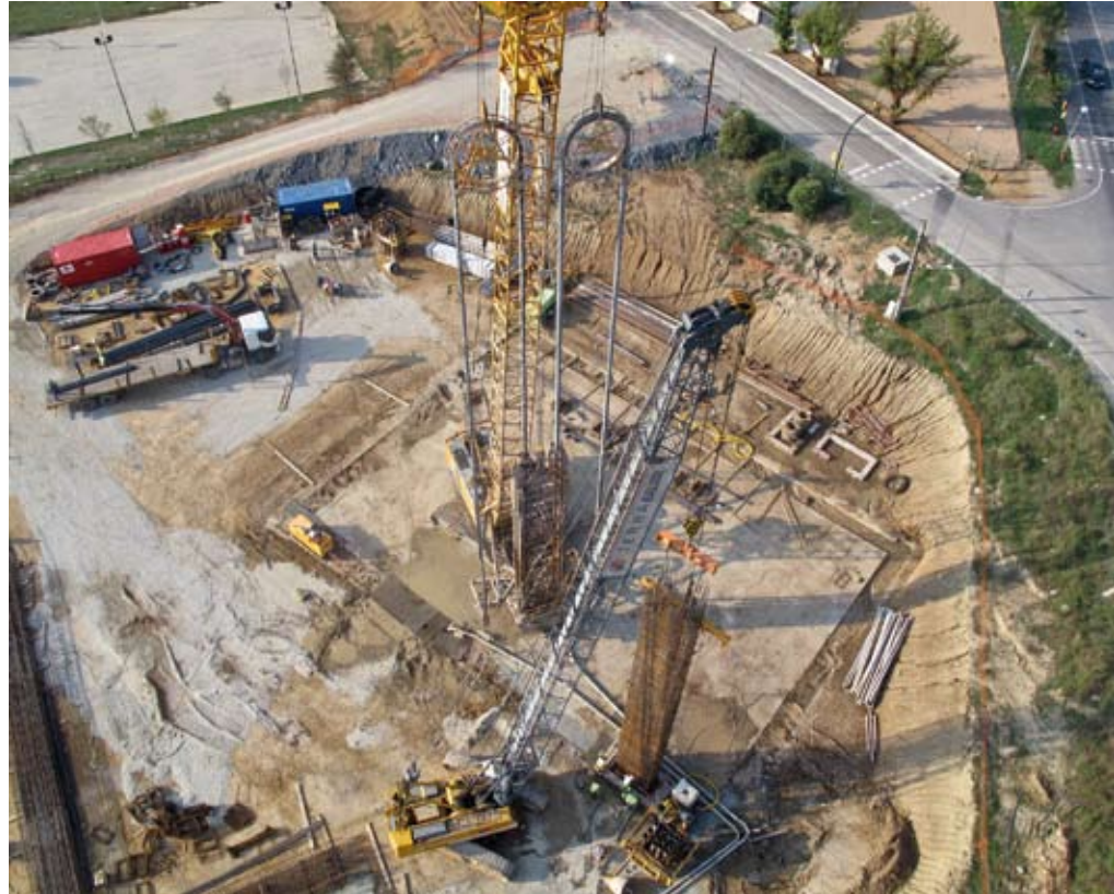
Paroi Moulée Sant Pons Gérone, Espagne Ateliers de forage avec Hydrofraise
