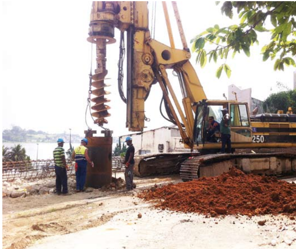
Chaîne d'hôtel Abidjan Client: GROUPE MANGALIS Ancrages, pieux forés et micropieux
