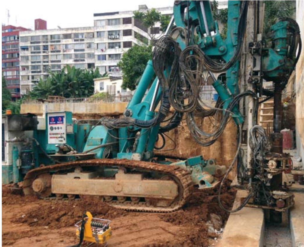
Abidjan, Côte d'Ivoire Ancrages, pieux forés et micropieux
