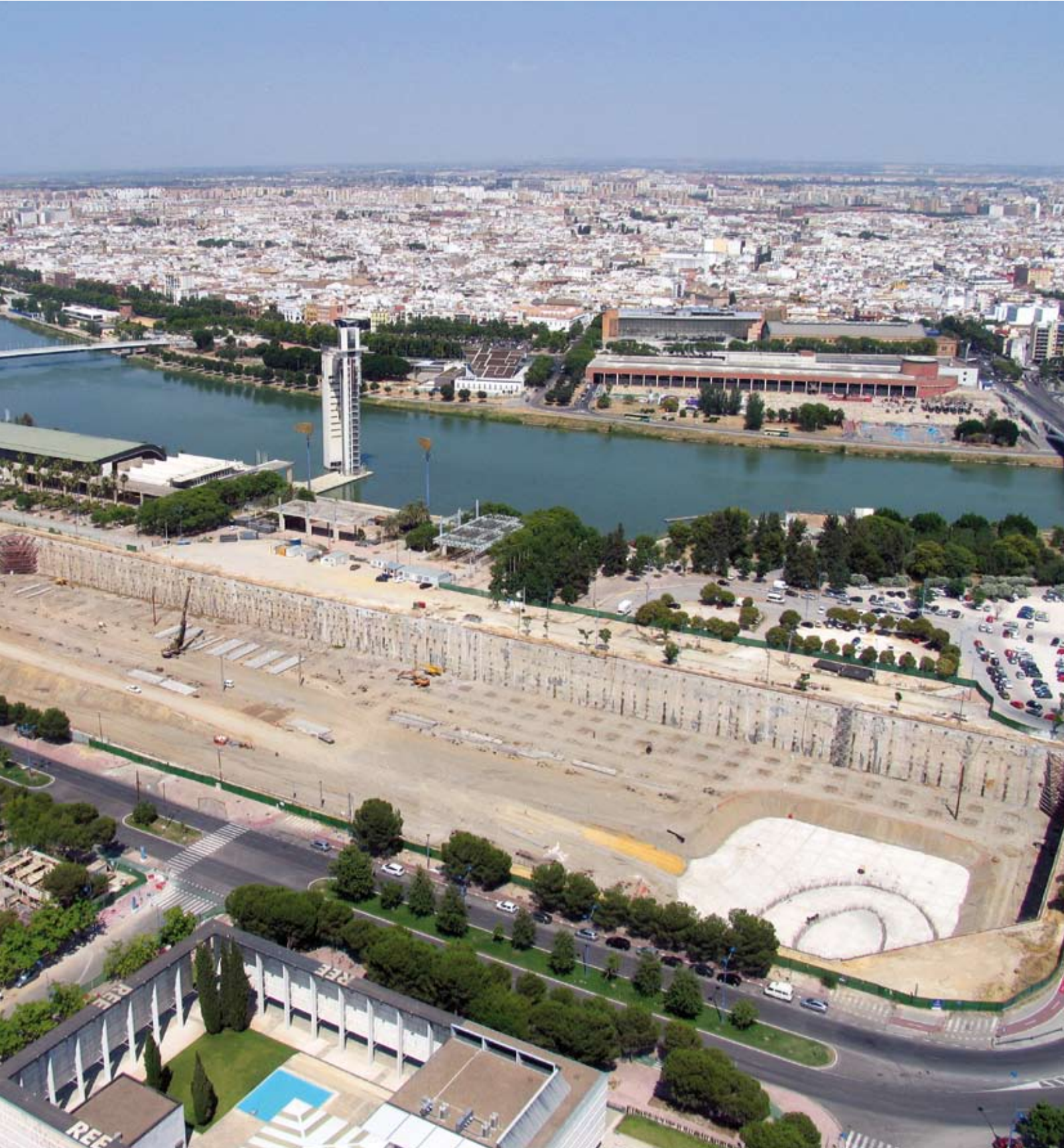
Murs de fondation et parois moulées du projet Torre Cajazol. Séville Parois moulées
